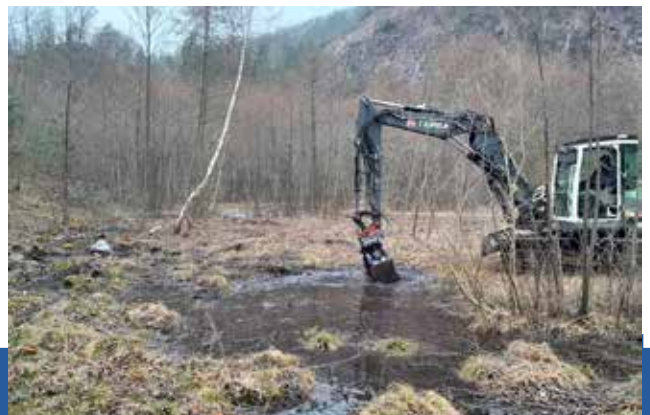
Travaux de restauration d'une mare dans les anciennes carrières de St-Nabor
