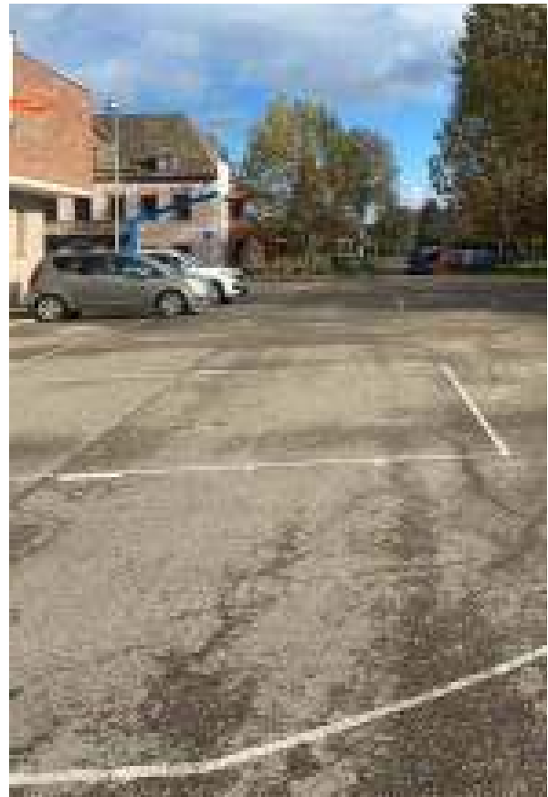
SOL IMPERMÉABLE DE LA SALLE DES FÊTES
