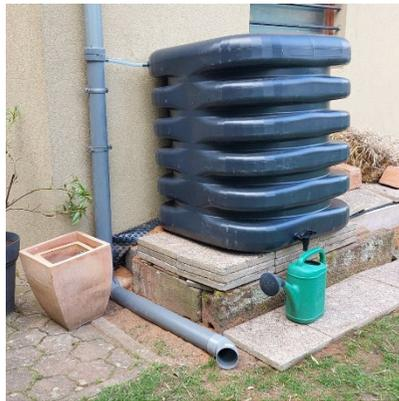
J'installe le dispositif de collecte et de filtration proposé avec la cuve. Ce dernier ne récupérant qu'une partie de l'eau s'écoulant dans la gouttière, je coupe le bas de la gouttière et met en place la technique d'infiltration de mon choix : ruissellement naturel, noues, jardins de pluie ...
