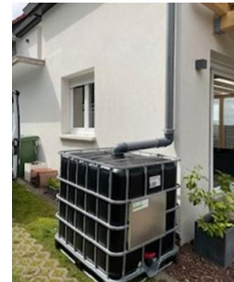
Je connecte directement la gouttière à la cuve. Le trop-plein de la cuve s'infilte ensuite sur mon terrain par une technique de mon choix.
